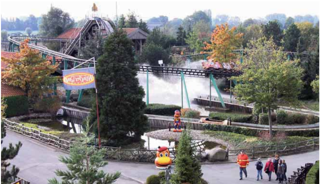
Isolierte Stromschienen U 30 in einem Fahrgeschäft
